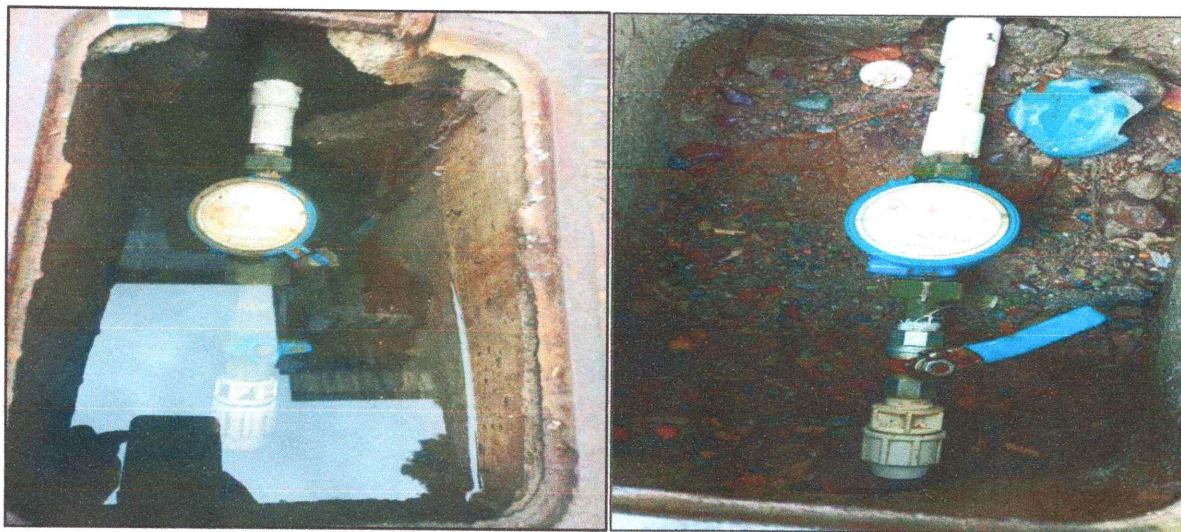
Ilustración 5, Arreglo de fugas perceptibles.
