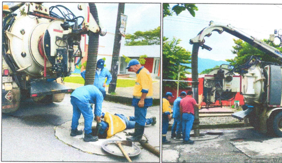
Ilustración 18, Mantenimiento y limpieza con equipo vector, 2025. Fuente: Empresa de Servicios Públicos AGUA VIVA S.A E.S. P
