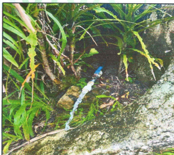
Ilustración 7, Instalación dispositivos conexiones fraudulentas, 2025. Fuente: Empresa de Servicios Públicos AGUA VIVA S.A E.S. P
