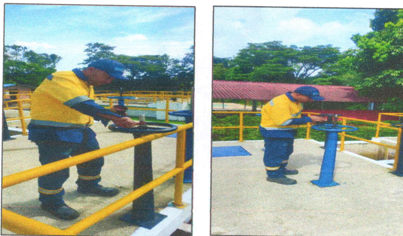
Ilustración 10, Mantenimiento preventivo válvulas PTAP, 2025. Fuente: Empresa de Servicios Públicos AGUA VIVA S.A E.S. P
