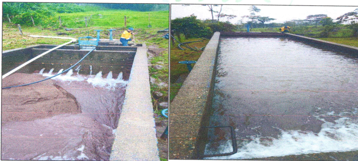
Ilustración 9, Limpieza desarenador 2025. Fuente: Empresa de Servicios Públicos AGUA VIVA S.A E.S. P
