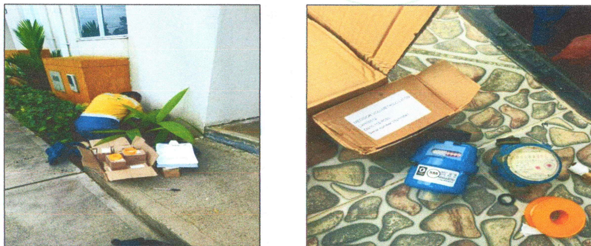
Ilustración 4, Instalación micromedidores, 2025.
