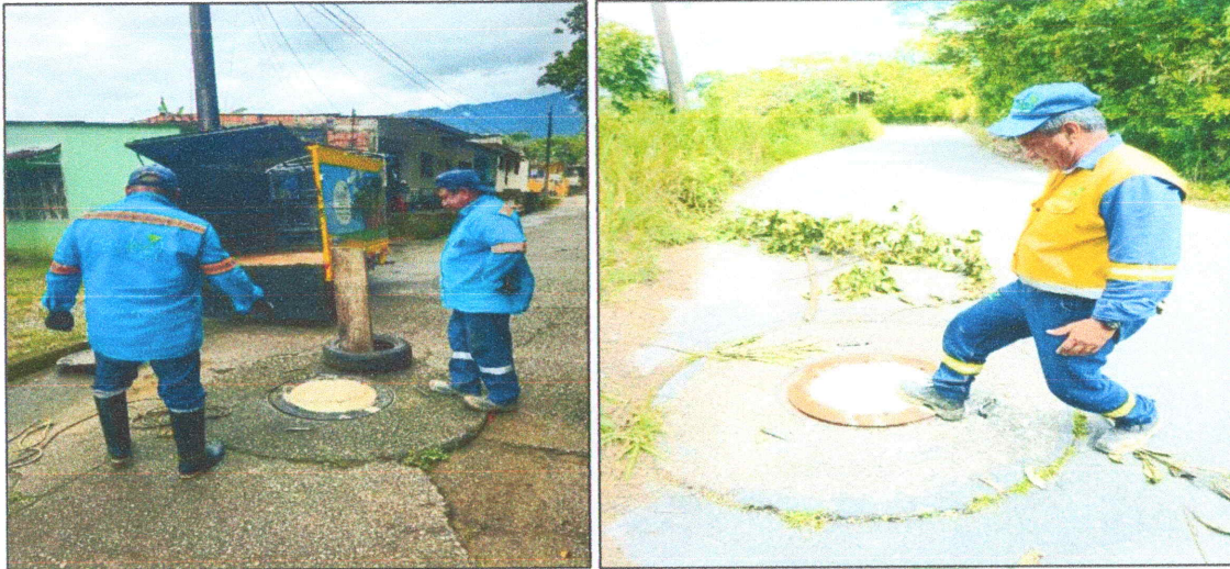
Ilustración 16, Reposición de tapas de alcantarillado, 2025.
